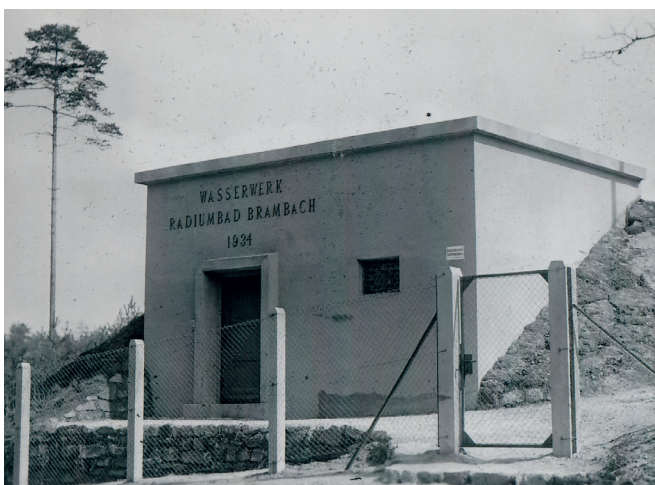
Das Bad Brambacher Wasserwerk
